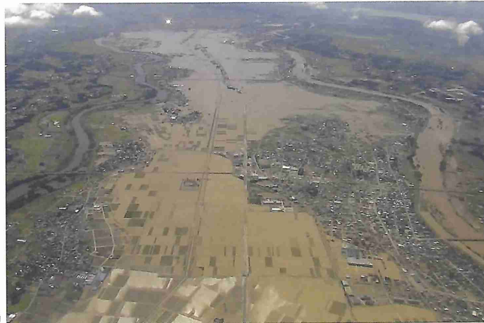
写真提供：国土交通省関東地方整備局
